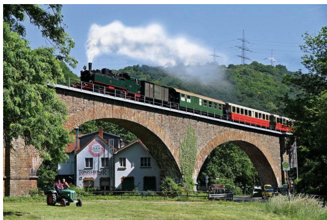
Viadukt der Brohltalbahn
